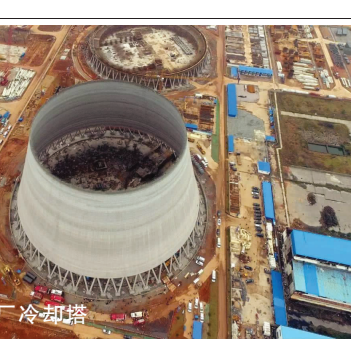
建设中的电厂冷却塔
