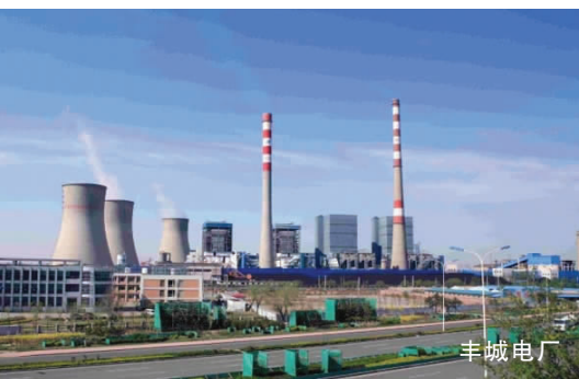
2016年11月24日, 江西省丰城电厂三期扩建工程D标段冷却塔平桥吊倒塌, 造成上面模板混凝土
