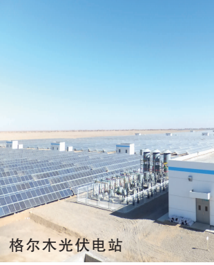
格尔木光伏电站
