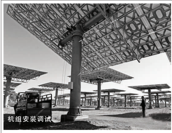
机组安装调试
