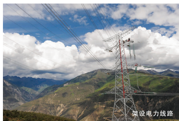
架设电力线路
