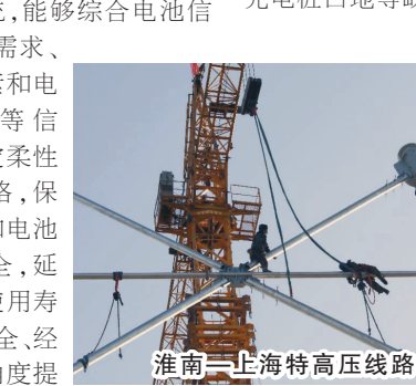
海南三上海特高压线路新工工艺施工
